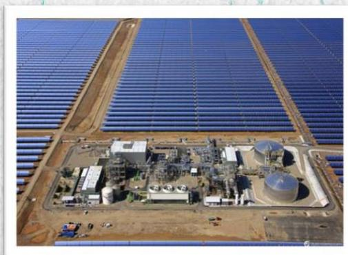
*Legenda: Planta termosolar com tecnologia de espelho de cilindro parabólico*
